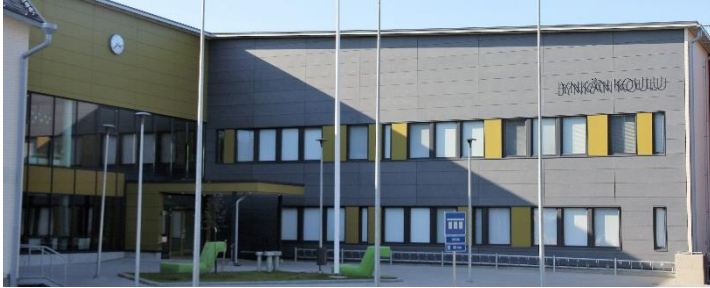
Koulu 2017, 6300m 2 , maalämpö
