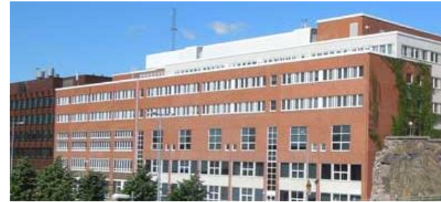
“Smart Office”, 14 000m 2 , peruskorjaus 2020
